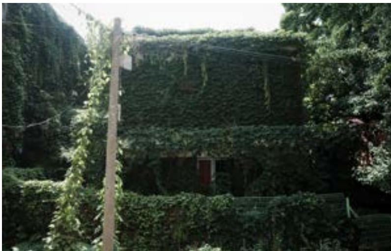
220718_담쟁이 폐가 앞 전봇대_박혜인
